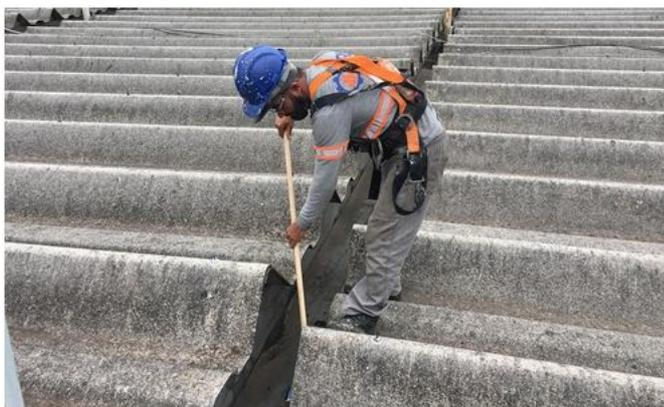
Além da limpeza das calhas (foto) e da troca de calhetas, a manutenção no telhado do MLP também envolve a substituição das placas metálicas
