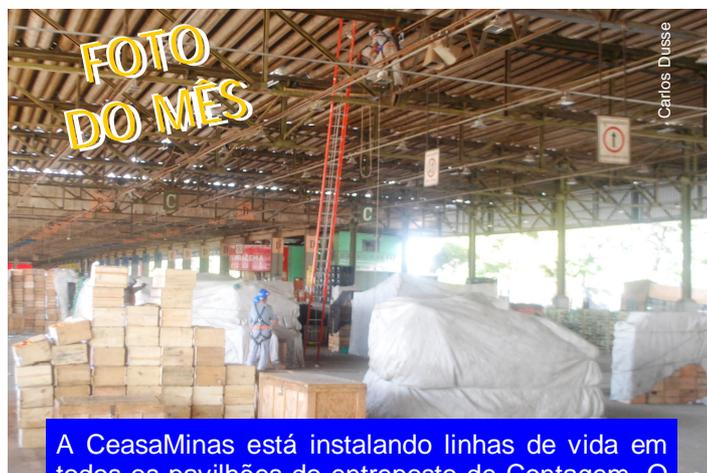
A CeasaMinas está instalando linhas de vida em todos os pavilhões do entreposto de Contagem. O serviço já foi realizado no pavilhão S e também no MLP. O equipamento é de uso obrigatório para manutenção nos telhados dos pavilhões, como troca de telhas quebradas.
