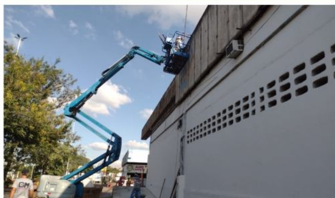
A CeasaMinas segue realizando a retirada das platibandas de concreto do entreposto de Contagem. Até agora, 80% do serviço já foi executado. A previsão de conclusão é até junho
