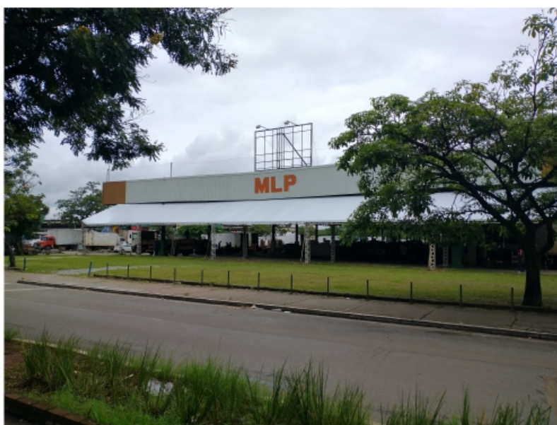
Cobertura ficará instalada até o fim do período chuvoso
