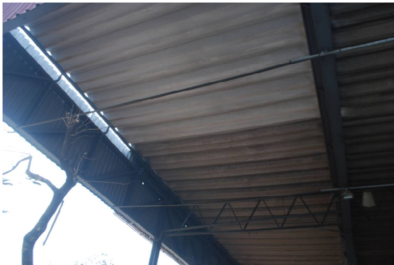
Foto das telhas novas, instaladas no MLP.
