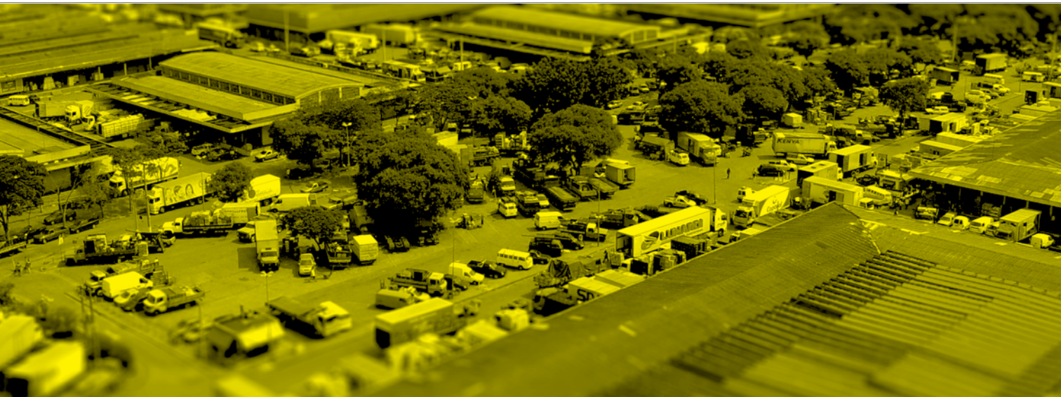
Espaçamento padrão de 30 metros entre os pavilhões não comporta atuais carretas
