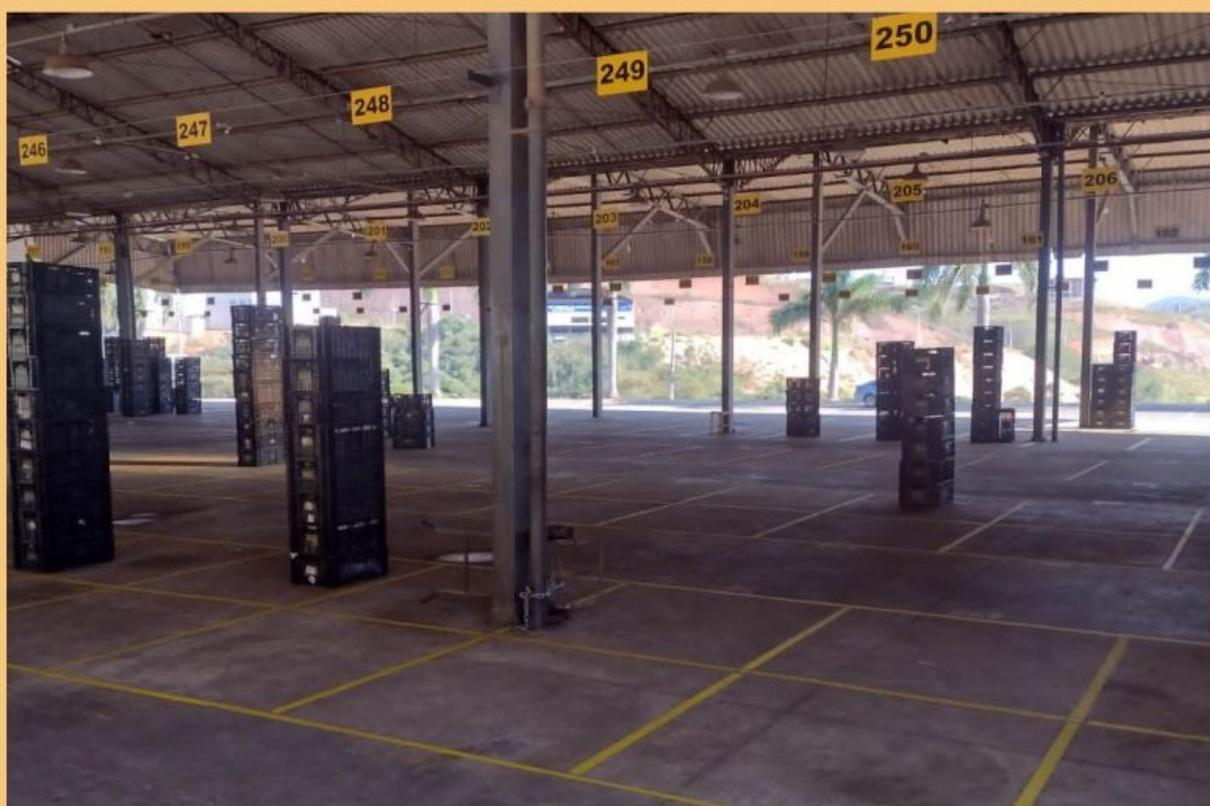
*Além de deixarem os números mais visíveis, as placas suspensas, apesar de leves, têm uma durabilidade muito maior, pois são feitas de ACM, material composto pela junção de duas chapas de alumínio com uma chapa de polietileno em seu interior.*
